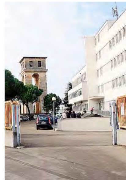
La sede leccese dell'Acquedotto
