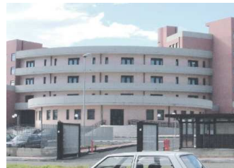
Nella foto una veduta dell'ex ospedale di Mottola
