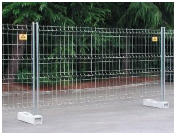
Delimitazione delle aree esterne a disposizione per le operazioni di scarico e movimentazione del materiale con pannellatura modulare prefabbricata in acciaio zincato su basette in cls
